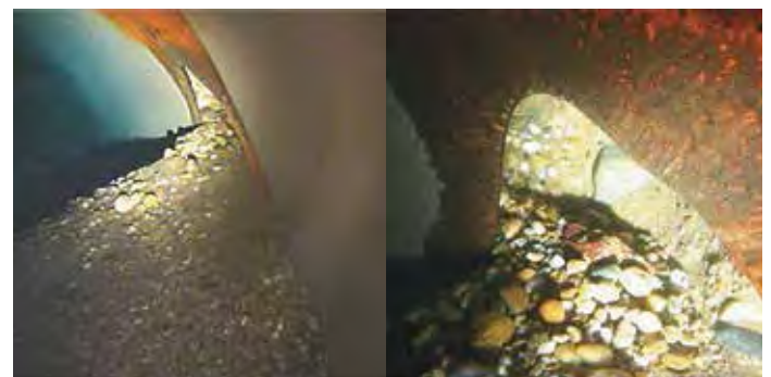
9-10. ábra - Csőfal héjkitörés és Duna meder felöli víz- és hordalék bemosódása
