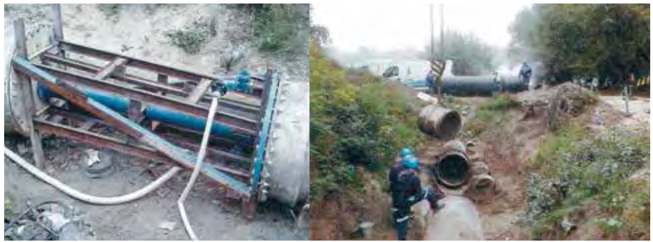
16-17. ábra - Partoldali vezeték és csomópontok kiépítése, a sikeres nyomáspróbát követően
