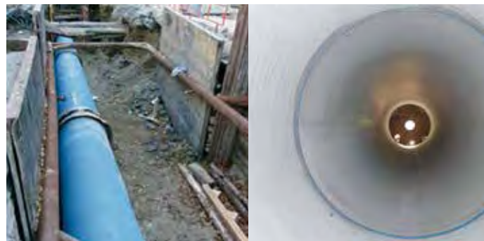
21-22. ábra – Munkagödör kialakítása és az új vezeték szakasz állapotfelmérése kamerás vizsgálattal
