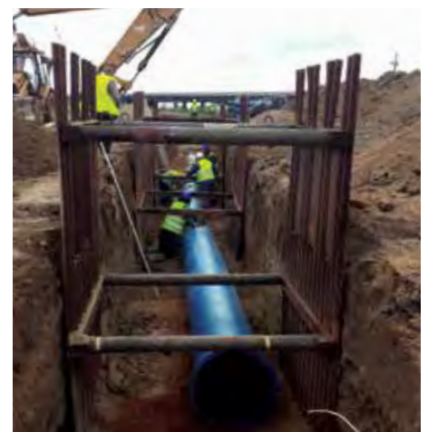
Miskolc, M30 DN600, Natural gőv csövek beépítése
