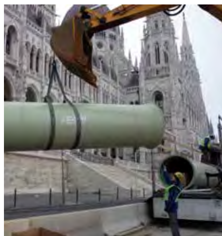
Kossuth tér DN1200-kiváltás, passzív gőv csövek érkezése
