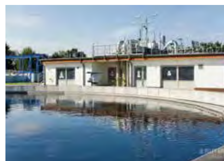
A biológiai tisztítás kiszolgáló épülete (vegyszer és hulladéktároló helyiségek, mechanikai előtisztítás) és az utóülepítő
