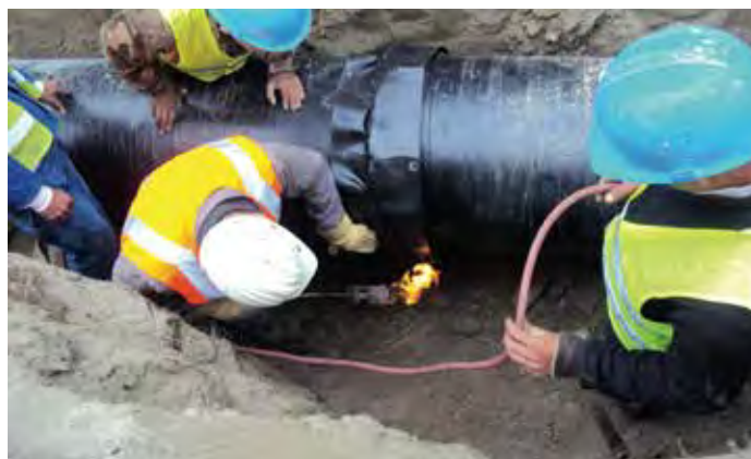
A zslugormandzsetták installálása
