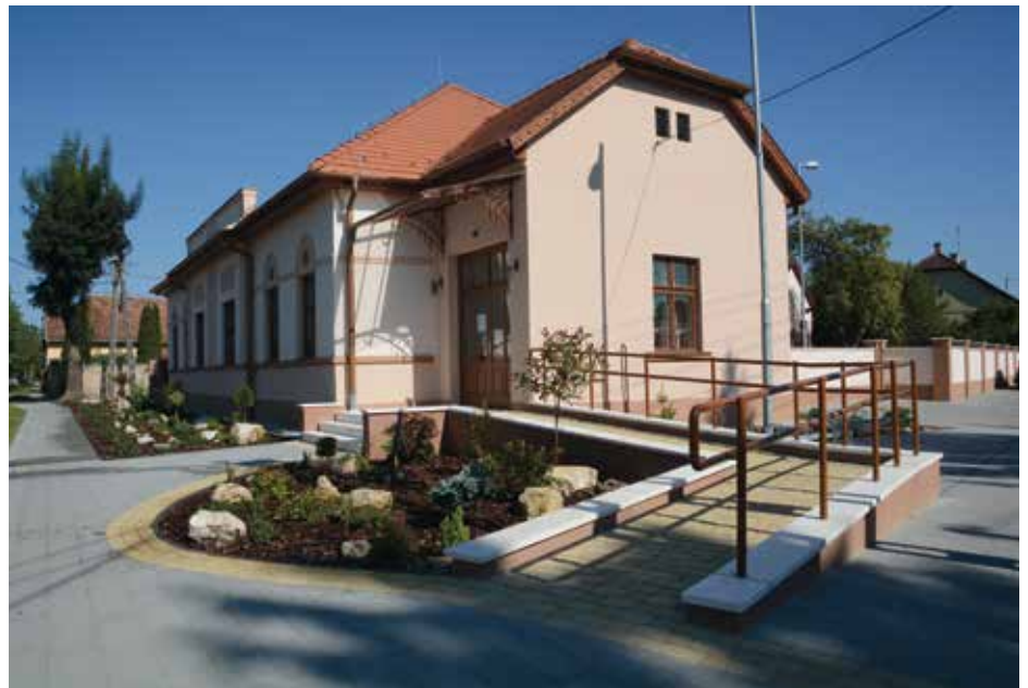
A 2014-ben átadott, új Nagykőrösi Üzemmérnökség központja (Fotó: Temesvári Péter)
