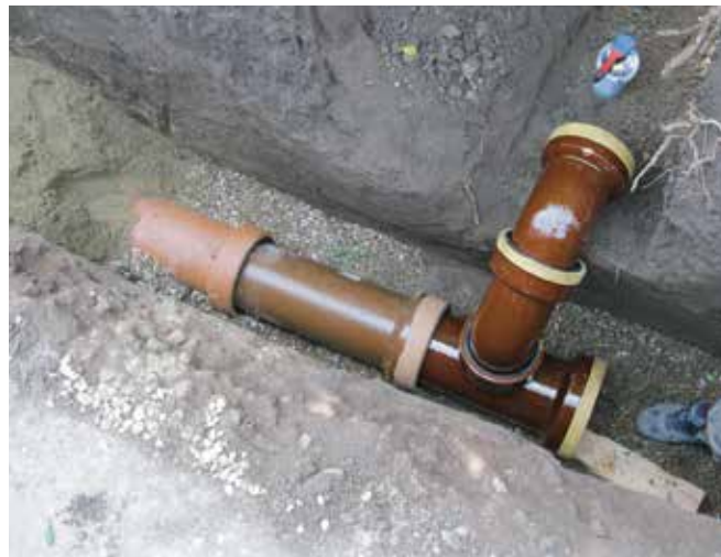
Bekötés rácsatlakozásának kialakítása
