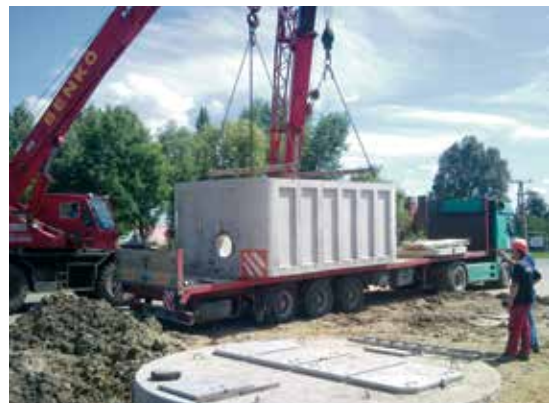
Új végátemelő építése
