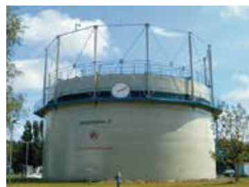
Stahndorf tisztítótelep biogáztartálya (Forrás: www.si-cor.de)
