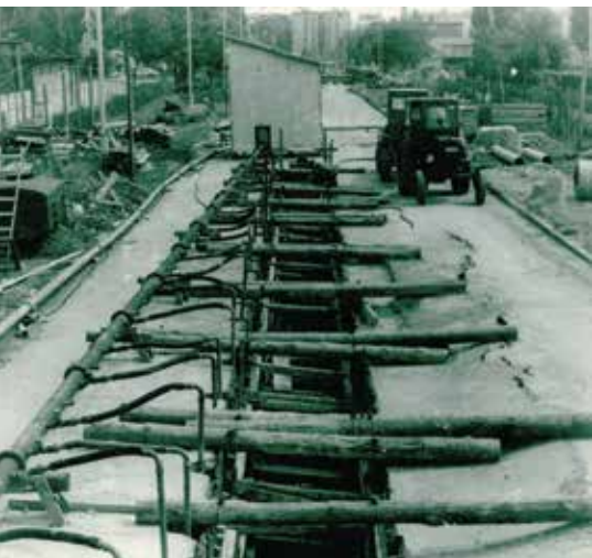
Csatornahálózat építése Békéscsaba belvárosában a '70-es években
