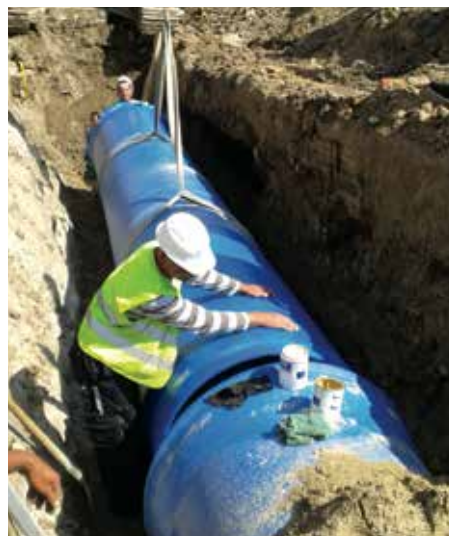
NÁ 1000 mm-es gömbgrafitos cső fektetése
