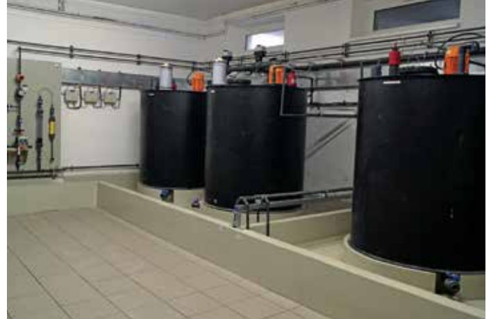
5. kép: Vegyszerbekeverő tartályok
