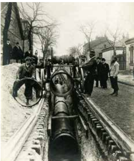
Öntöttvas cső fektetése 1904-ben
