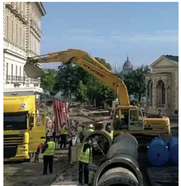
Feszítettbeton főnyomócső cseréje duktilra (NA 1000 mm)
