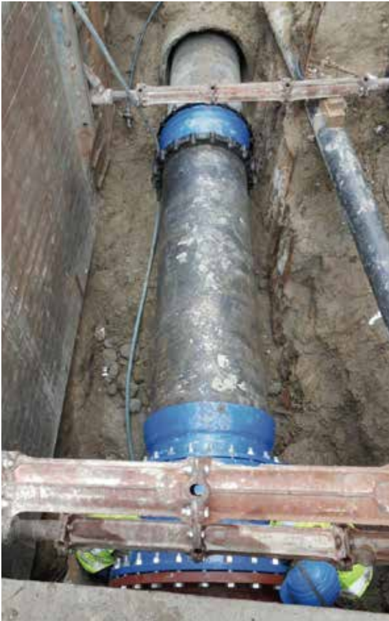
Duktilcső behúzása feszítettbeton vezetékbe NO-DIG eljárással
