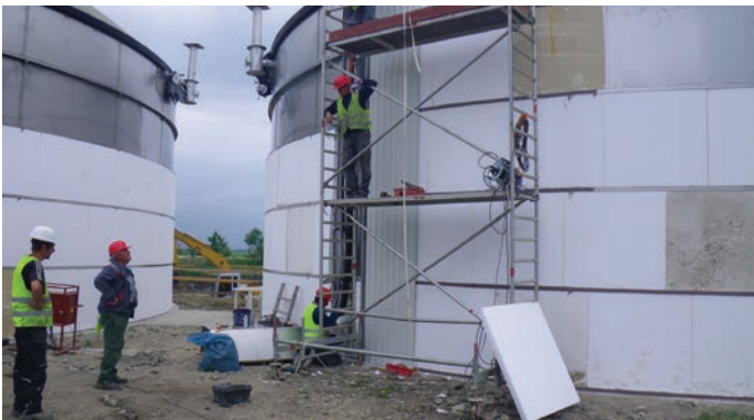
Weltech rothasztók hőszigetelése
