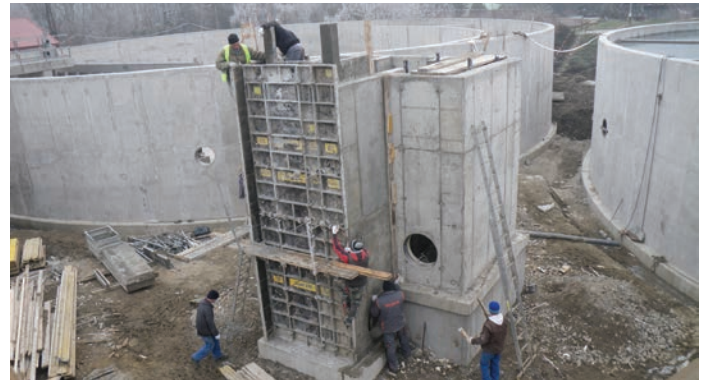
C-Tech osztómű és a medencék építése
