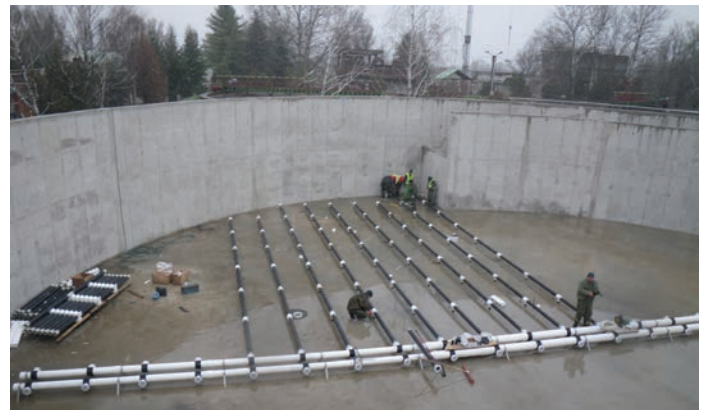
C-Tech medencelevegőztető rendszer építése
