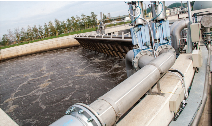
A próbaüzem lezárása óta stabilan tartja a telep az előírt határértékeket
