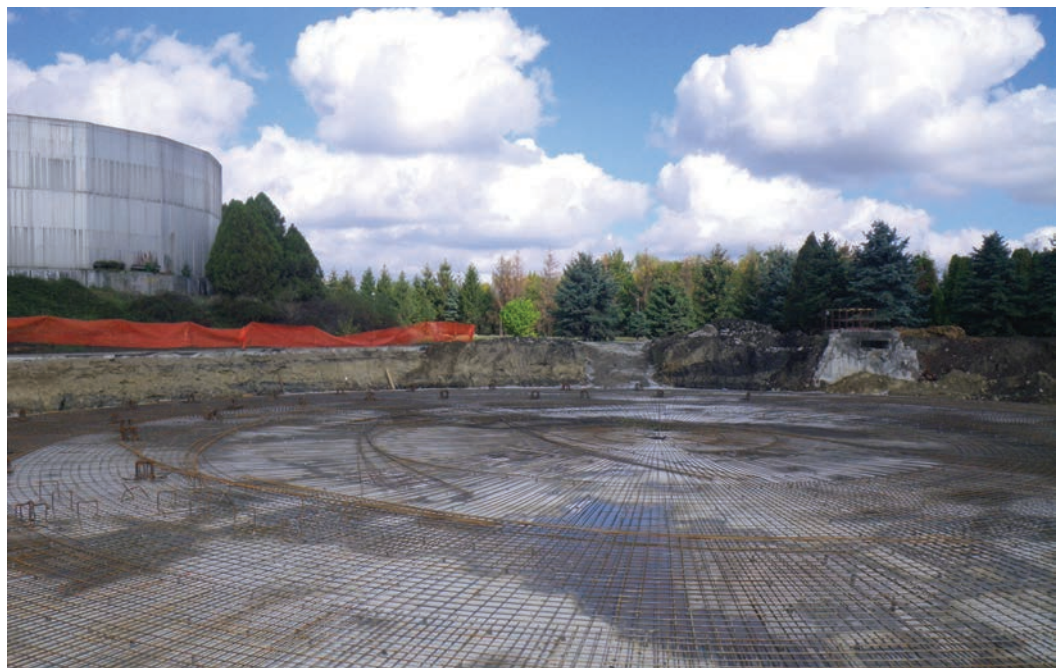
C-Tech medence alaplemez-vasalása - háttérben az egyik elbontásra ítélt csepegtetőtest
