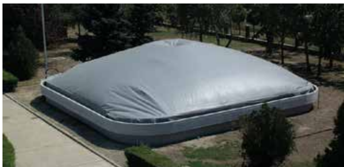
1. kép: Holland tervek alapján épült rothasztó
