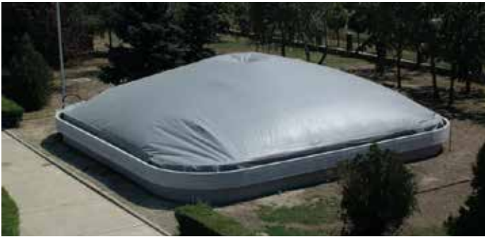
1. kép: Holland tervek alapján épült rothasztó
