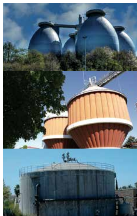
1. ábra Rothasztóformák összehasonlítása (tojás, kontinentális, angolszász)
