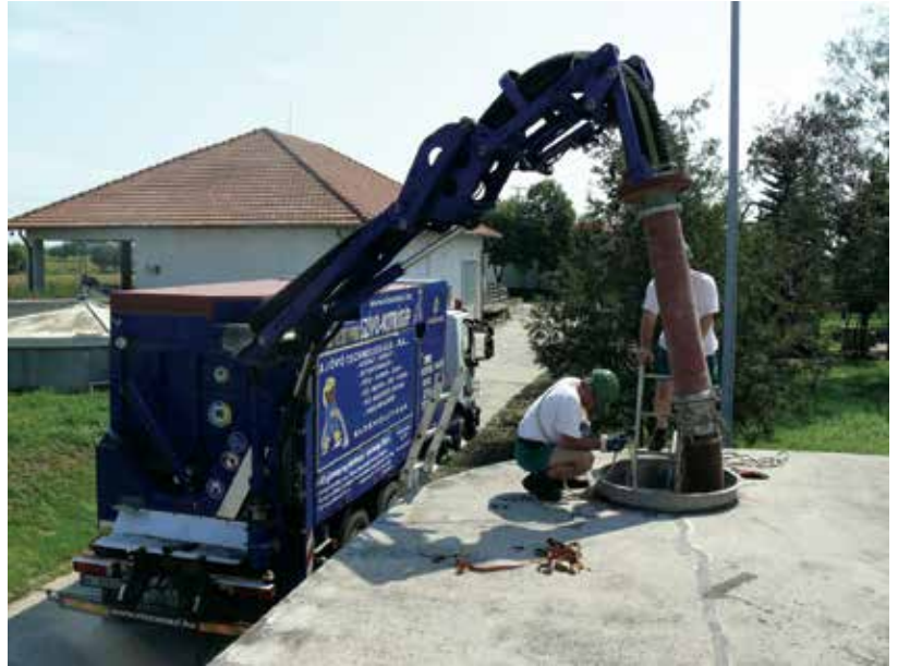
3. kép: Üledékkitermelés az ipari szívó-kotró géppel
