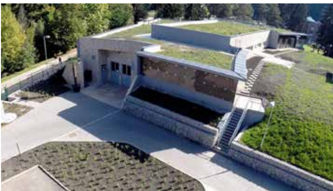
Az új technológiai épület északi homlokzata
