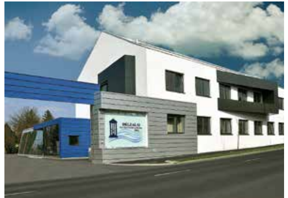
Kisfaludy utca – központi épület
