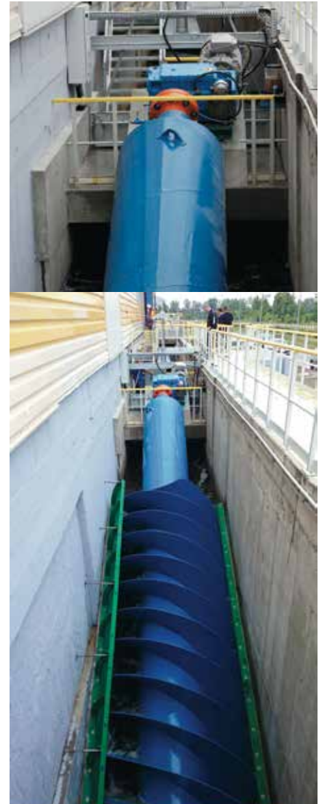
Törpe vízerőmű üzem közben
