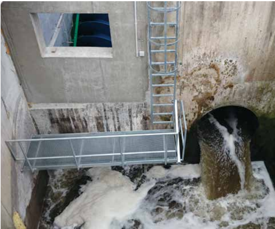
Kivitelezési munkálatok a törpe vízerőmű vasbeton csatornájában folyamatos üzem mellett
