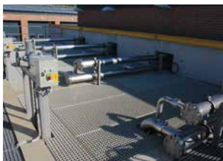
Az MBR-membrán medencéi - LEAP-levegőztetéssel
