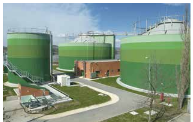
Észak-pesti Szennyvíztisztító Telep - Rothasztók
