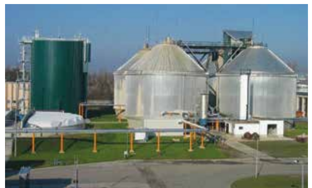
Dél-pesti Szennyvíztisztító Telep - Rothasztók
