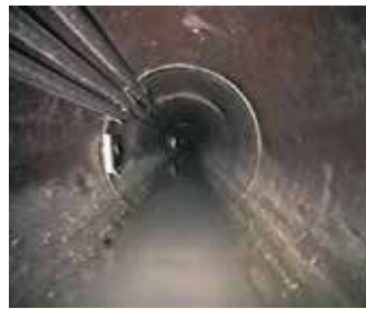
„FAST” rendszer DN400 mm-es csatornában, 3 év üzem után
