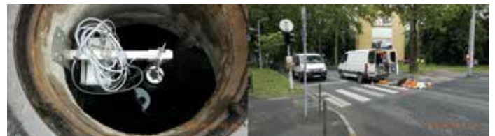
4. sz. fotó: NIVUS EASYTREK ultrahangos szinttávadó elhelyezése
