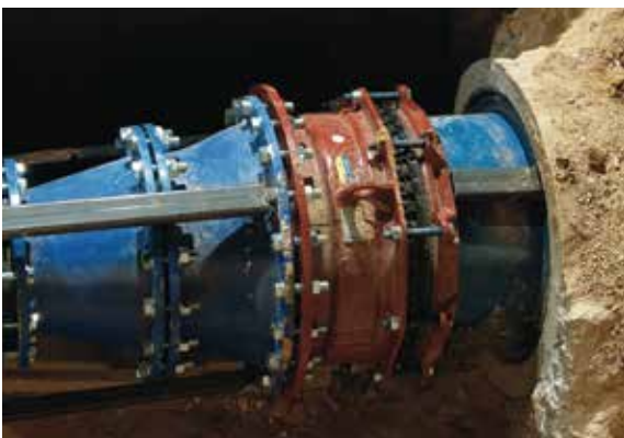
A befűzött csőszakasz csatlakozása
