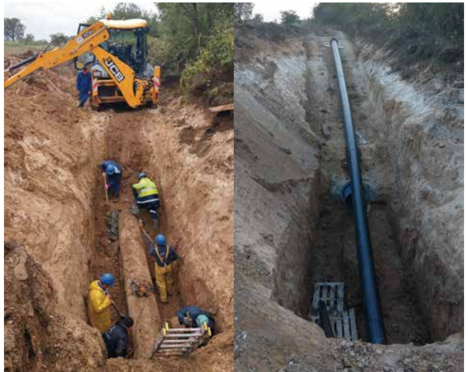
A földmunka és a csőkígyó betolása
