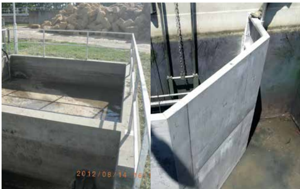
Szalagszűrő tisztított vízből való mosása fonalasodás esetén nehézkes, de egy terelő fallal kizárható a lebegő anyaggal terhes víz és ivóvízzel való szalagmosás lehetővé válik (megállapodás előtt és után)
