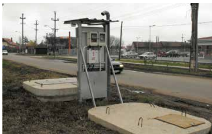
Új végátemelő szivattyúház építése
