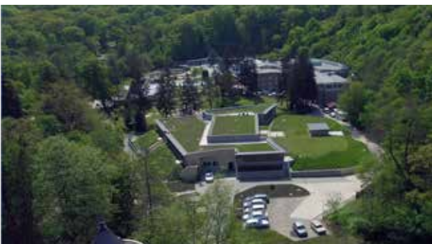
1. ábra: A miskolctapolcai vízmű látképe – Közép-Európa egyik legnagyobb teljesítményű ivóvíztisztító ultraszűrője 1500 m 3 /h teljesítménnyel
