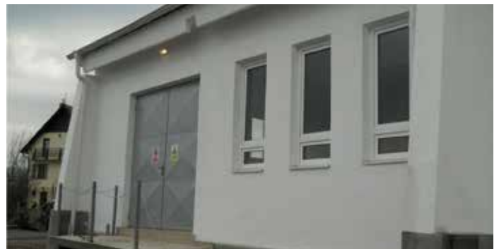
Nyersvíz-fogadó és vegyszeradagoló
