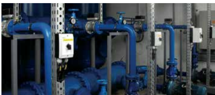
A felújított szivattyúház a vízműtelepen
