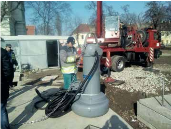
Az átemelő szivattyú beemelése
