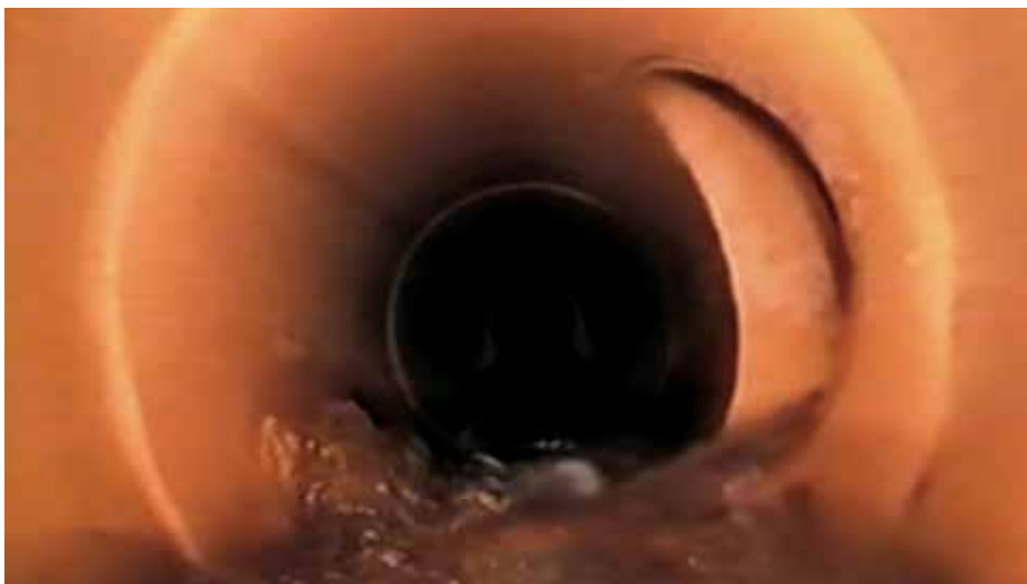
1. ábra: Egy 1974-ben lefektetett csatornacső kamerás vizsgálata
