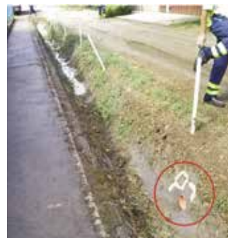
Szikkasztóárok átkötése az új szennyvízcsatornára
