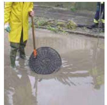
Út víztelenítése szennyvízcsatornába
