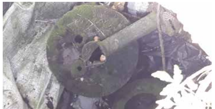
Nem teljes mértékben zárt kútfej, a kútaknában pedig oda nem illő anyagok találhatóak (a szerző saját felvétele, 2019)
