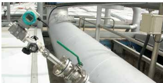
Pitot-csőves térfogatáram mérés szennyvíztelepen
