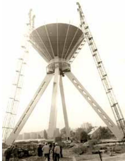
Az épülő mosonmagyaróvári víztorony
