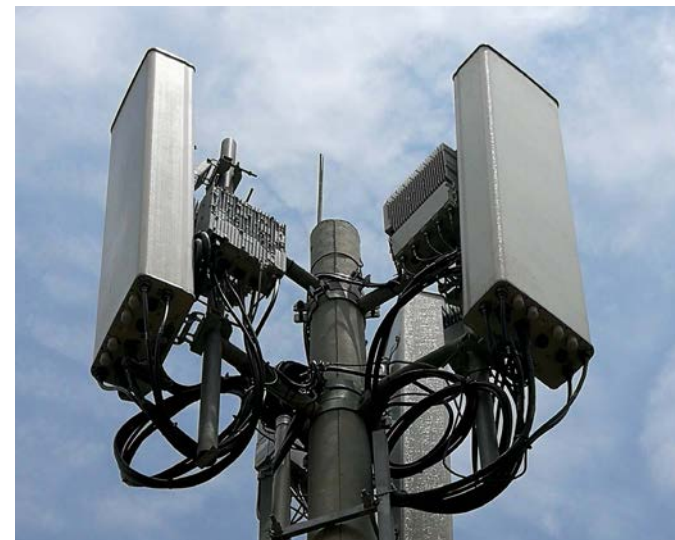
4. kép: Toronyra rögzített 4G bázisállomás-antennák hagyományos megjelenése. Forrás: Airplux Technologies Ltd. https://airpluxtec.com/4g-base-station-antenna-in-tower/ ; letöltés: 2021. 12. 27.
