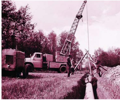
Mura I. távvezeték építése
