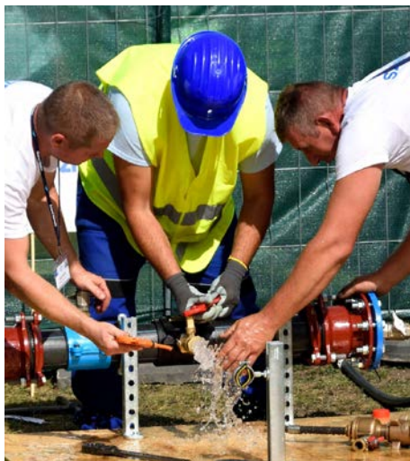
Vezetékűrités. Forrás: Fővárosi Vízművek Zrt.
