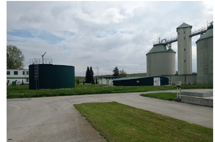
9. kép: iszaptározó medencék (fotó: Mészáros Imre)
