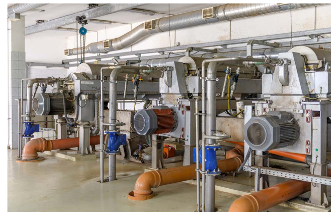
4. kép: iszapvíztelenítő centrifugák (fotó: Hajdú László)
