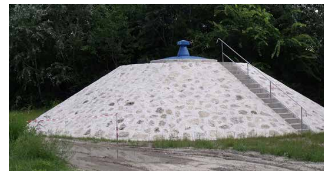
4. fotó: Csáposkúttá átépített aknakút
