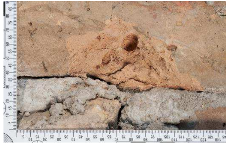
18–19. számú fényképek Becsapódási kráter vakolt (bal) és vaknyílás (jobb) téglafalon
