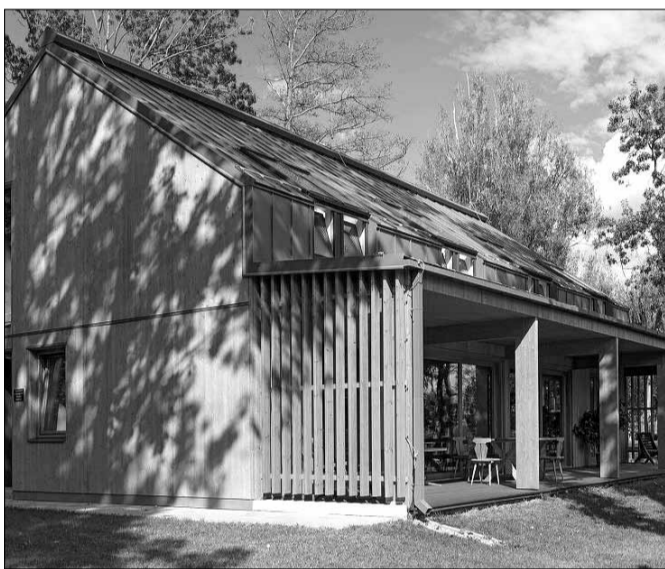
Az épület fő térszervező eleme a közösségi terület, amely nagyméretű üvegfelületekkel nyílik a teraszra
