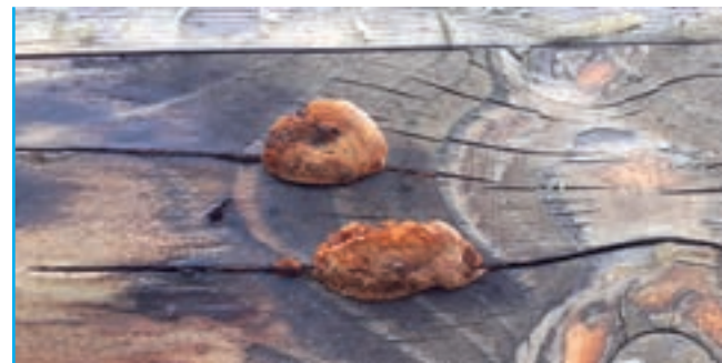
Egyes gombafajok megtámadhatják a már kiszáritott, feldolgozott, beépített, sőt felületkezelt építőipari faanyagokat is. Kertekben leginkább a pergolák szerkezetét károsítják
