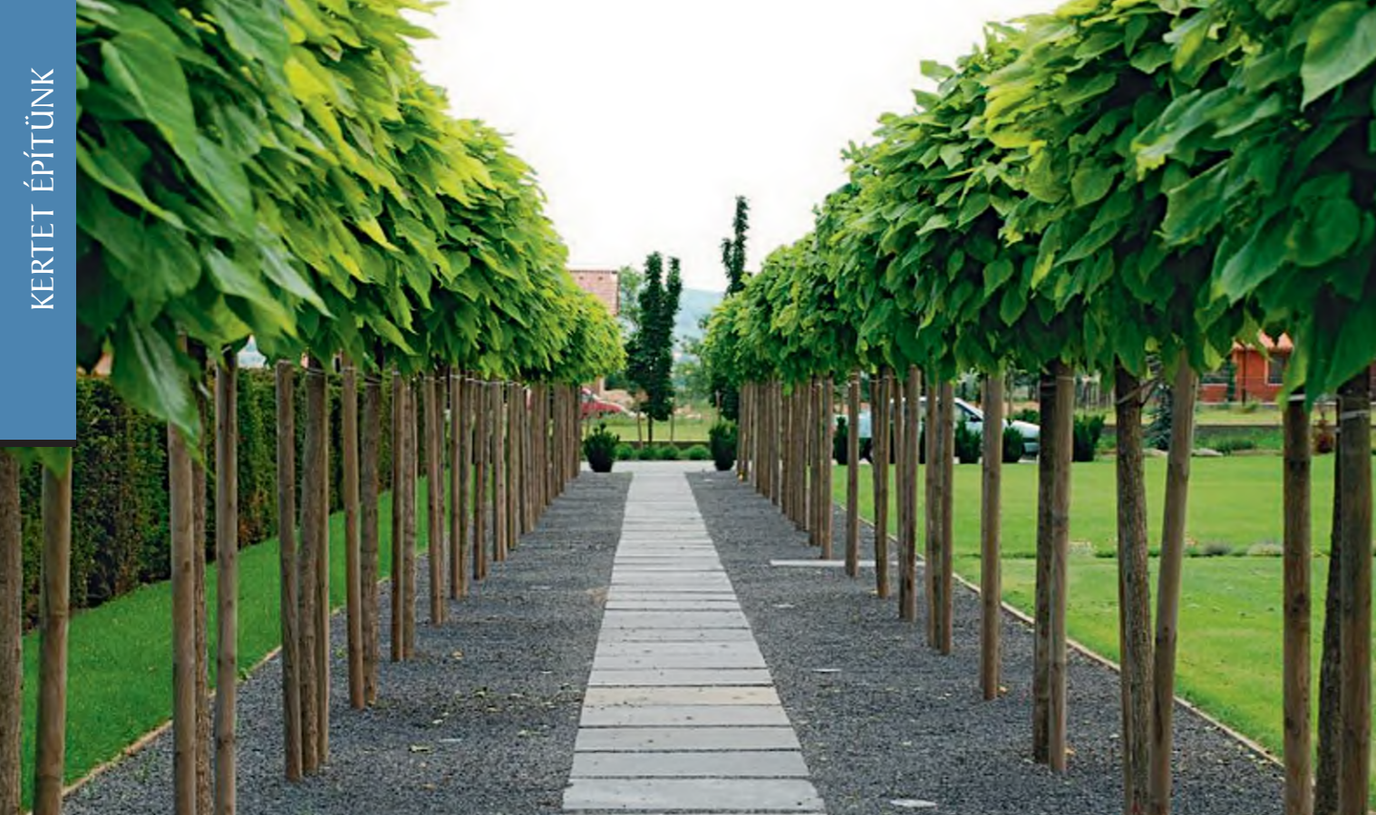
A széles hézagú beton, bazalt, gránit térköveket helyezünk megfelelően tömörített zúzalékalapra, a hézagok besöppréséhez homok helyett inkább kis szemcseméretű zúzalékot használunk
