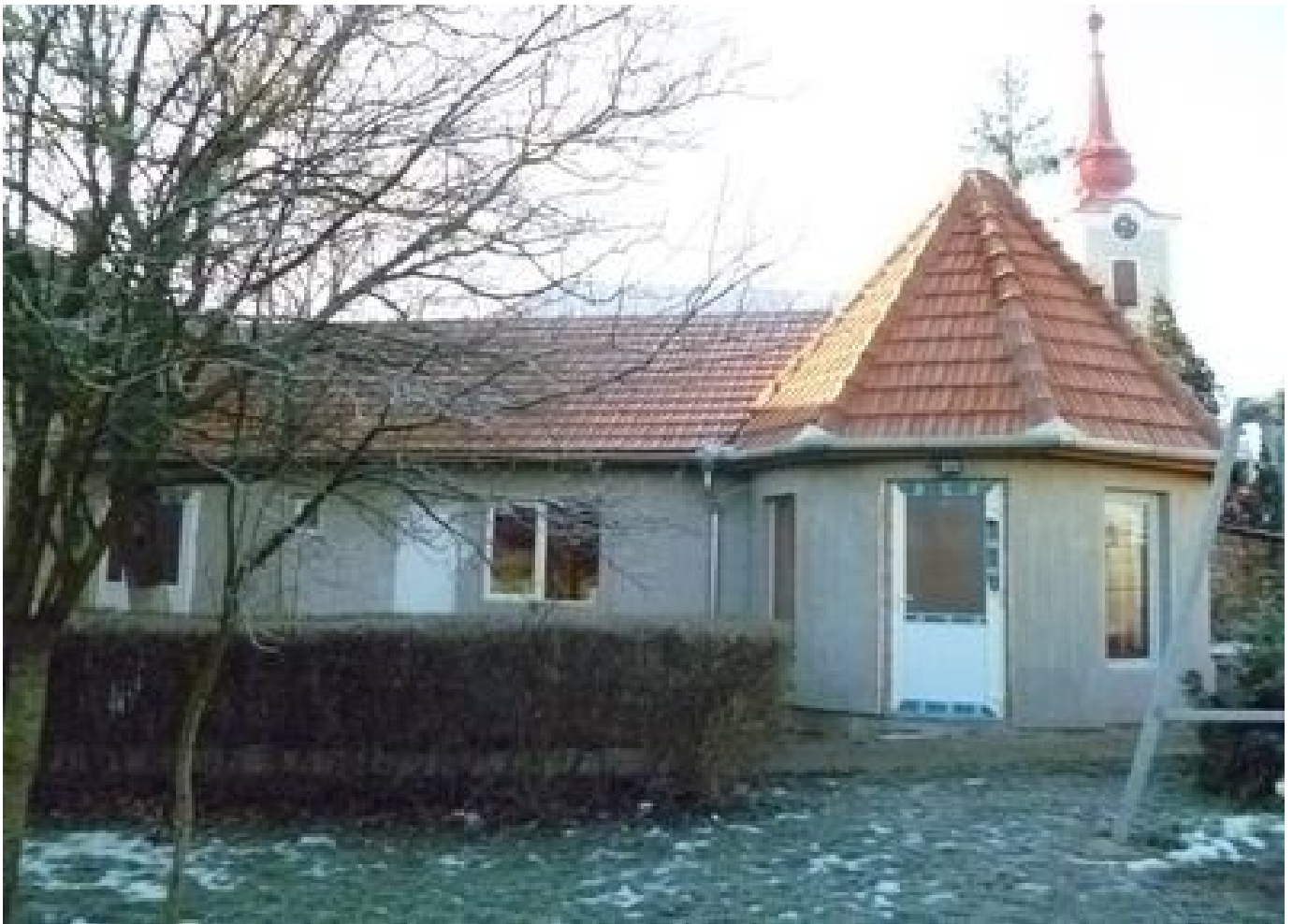
A HEGYKÖZCSATÁRI ÓVODA BŐVÍTETT RÉSE.
