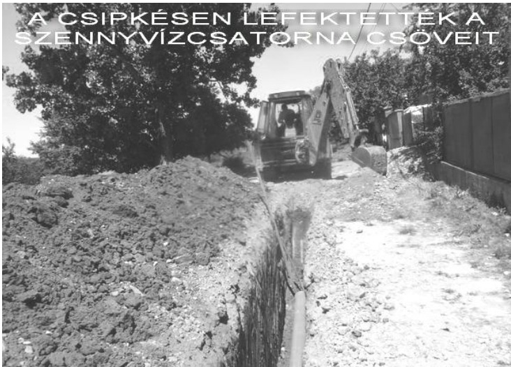
A CSÖVEK LEFEKTETÉSE UTÁN A FÖLDET ELTAKARÍTJÁK A JÁRDARÓL ÉS AZ ÚTRÓL
