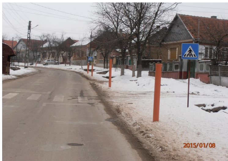
A KIÁLLÓ CSÖVEK JELZIK A SZENNYVÍZCSATORNA AKNÁINAK HELYÉT
