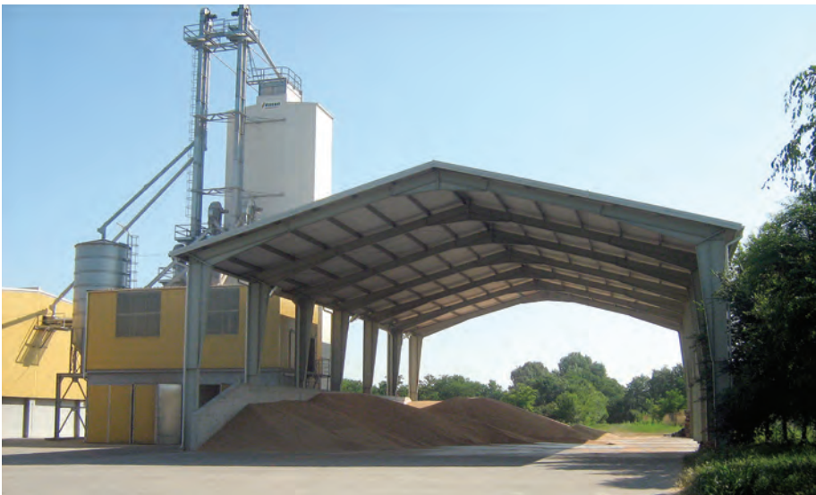
4. a., b. kép. Korszerű előtárolóval és beépített anyagmozgató rendszerrel kialakított tárolótér
