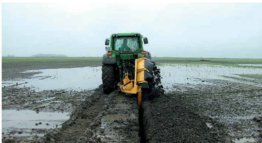
6. kép. Rotoros réselő munka közben
