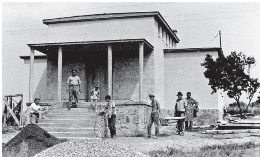
A ravatalozó építése
