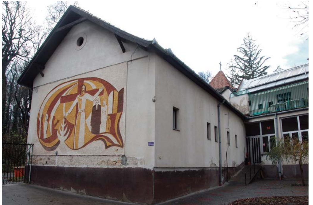
A Sarepta Báthori utcai épületszárnya
