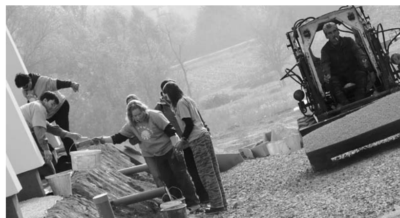
Hidas – végső simítások a most épülő református templom szigetelésén
