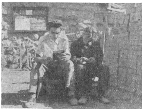
Egy építkezés ebédszünetében
