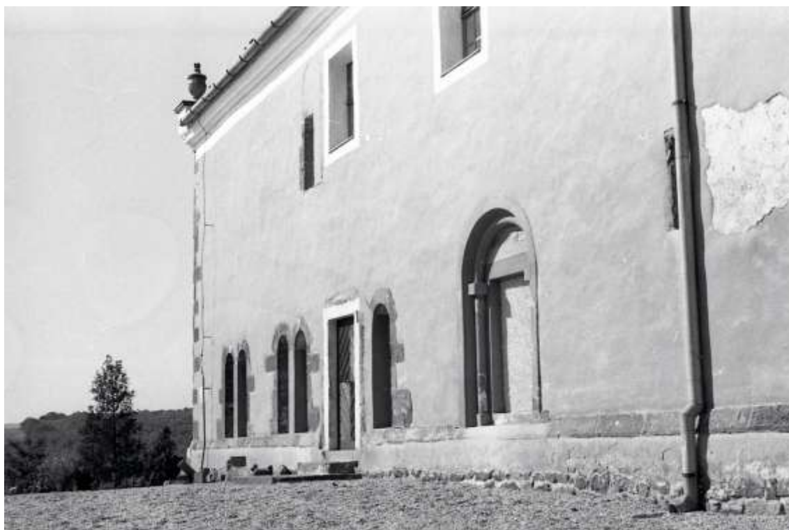
Felsőörs – Dózsa tér, római katolikus volt prépostsági templom. (A felvétel 1970 körül készült.)
