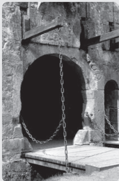
A középkori várak lakóinak védelmét biztosították a várfalakat körülvevő, mély árkok fölött átvezető, éjszaka, illetve ellenség közeledtekor láncokkal felhúzható függőhidak
