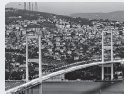
A világ első, kontinenseket összekötő hídja, a Márvány- és a Fekete-tenger között húzódó Boszporusz tengersizor felett átívelő, az 1970-es években épült, Isztambul európai és ázsiai részét összekapcsoló Boszporusz-híd
