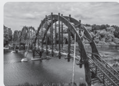
A régi idők fahídjainak emlékét őrzi a Kányavári-szigetre vezető, ragasztott gerendákból álló, háromnyílású – a Kis-Balaton jelképévé vált – gyalogoshíd
