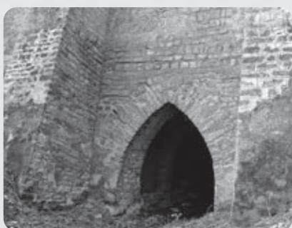
Világviszonylatban egyedülálló az 1800-as évek elején épült, gótikus hatású – csúcsíves boltozatú, támpillérekkel ellátott, a település főutcáját megszakító mély árok felett átívelő – olaszliszka kőhíd
