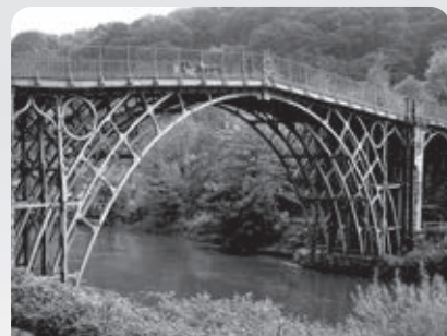
A világ első, teljes egészében öntöttvasból készített hídja, az angliai Severn folyón átívelő, 1781-ben átadott Iron Bridge (Vashíd) ma a világörökség része
