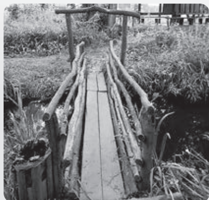
Patak fölött átfektetett, összekapcsolt, deszkázattal burkolt és cölöpökkel alátámasztott, hosszú gerendákból épített, korlátokkal ellátott gerendahíd (pallóhíd)
