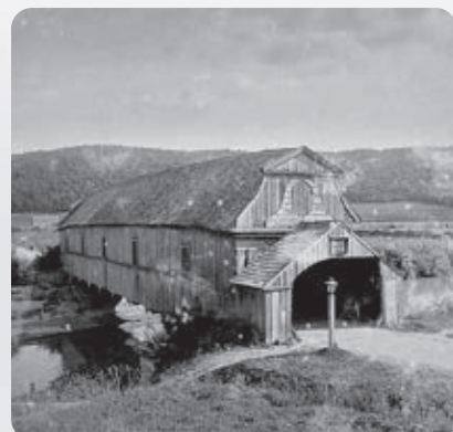
Az erdélyi fahidakat gyakran védték tetőzettel és deszka oldalfalakkal a csapadéktól és a napsütés szárító hatásától (a Nagy-Küküllő segesvári – az 1970-es árvíz során megsemmisült – fedett hídja)
