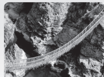
A perui inkák fűből, szalmából, nádból font függőhidakat feszítettek ki az Andok-hegység szurdokai fölött (a napjainkig megmaradt néhány ősi kötélhidat a helyi lakosok évente felújítják)
