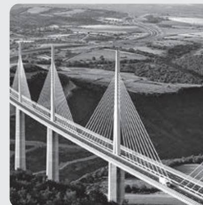
A Franciaországban 2002-ben átadott Millau-i völgyhíd 336 méteres pillérével a világ legmagasabb kábelhídja, amely egyúttal a leghosszabb (2460 m hosszú) ferde kábeles híd is
