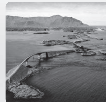
Az Atlanti-óceán fölé épült, 1989-ben megnyitott, a Norvégia partjainál húzódó szigetvilágot a szárazfölddel összekötő, 8,3 kilométer hosszú Atlanti-utat több gát, viadukt és híd képezi
