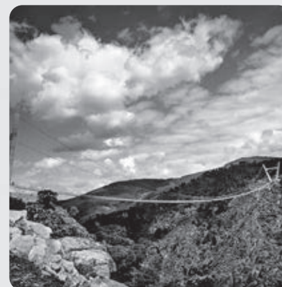
Portugáliában épült a világ leghosszabb gyalogos függőhídja, a Paiva folyó 176 méter mély szurdoka felett húzódó, 516 méter hosszú, hatalmas, V alakú tornyokból induló vaskábelek által tartott Arouca-híd
