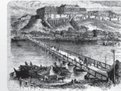
A jégzajláskor szétbontható hajóhidak nem pillérekre támaszkodtak, hanem lehorgonyzott és láncokkal egymáshoz rögzített csónakokra, tutajokra, kompokra (a Budát Pesttel összekötő hajóhíd 1844-ben)
