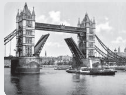
A 19. század végén épült, hatalmas pillérekön álló, acélszerkezetű – London egyik jelképévé vált – Tower-hidat a neogótikus tornyokkal határolt, hajók közeledtekor felnyitható hídszakasz teszi különlegessé
