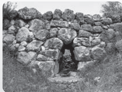
A legrégebb – máig használt – boltíves kőhíd, a gyaloghídként szolgáló görögországi Arkadiko-híd pontosan összeillesztett mészkösziklákból, kötőanyag nélkül épült Kr. e. 1200 körül
