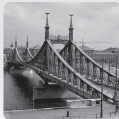
A világ egyik legszebbnek tartott csuklós-konzolos – előregyártott elemekből az építés helyén összeállított – hídja az 1896-ban Budapesten átadott, vasszerkezetű Szabadság (egykor Ferenc József) híd
