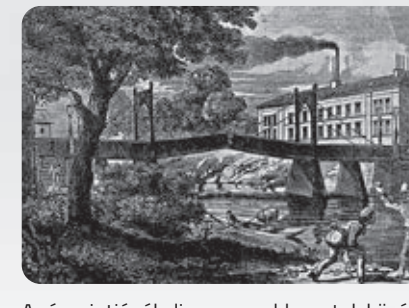
A víz szintjénél alig magasabb partok közé – a hajózást lehetővé tevő, csörlőkkel, láncokkal részben vagy teljes hosszukban felemelhető – felnyitható hidakat építettek (a Duna mellékágán az 1800-as években épült fahíd)
