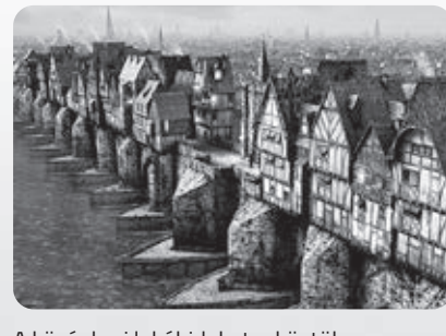
A középkori lakóhidakat – köztük a 12. századi London-hidat – a rájuk épült, gyakran többemeletes lakóházak, üzletek, műhelyek tették különlegessé (a karbantartást az épületek után fizetett adók fedezték)
