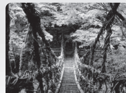
A japán szőlőhidakat hatalmasra növesztett szőlőindákból fonták, és járólécekkel, illetve korláttal tették stabilabbá, biztonságosabbá
