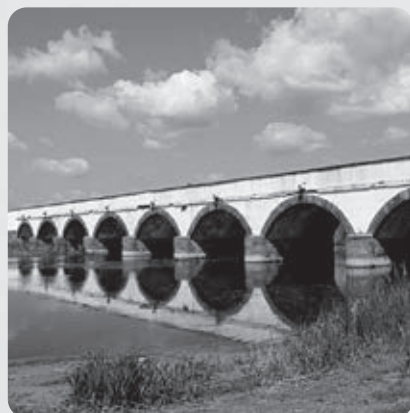
A Hortobágy jelképévé vált, faragott kővekből épült Kilenclukú híd Debrecen városa építtette az 1830-as években kereskedelmi forgalmának biztosítására
