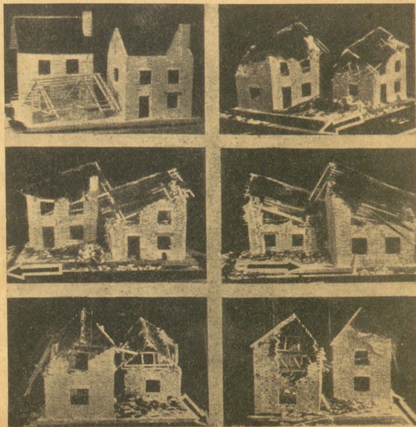
Normális épület jellegzetes meg- sérülése föld- rengés alkalmával
