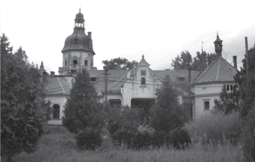
A felújítás előtti állapotok FOTÓ: ORBÁN ZSOLT
