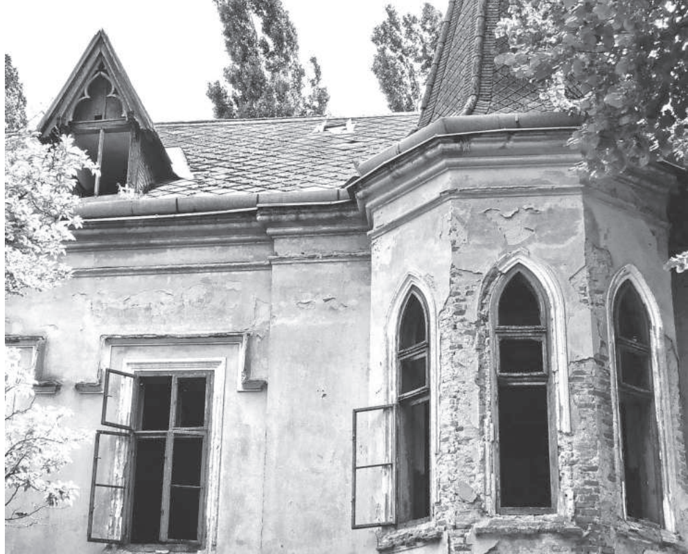
A főhomlokzat részlete (FOTÓ: BICSOK ZOLTÁN, 2007)
