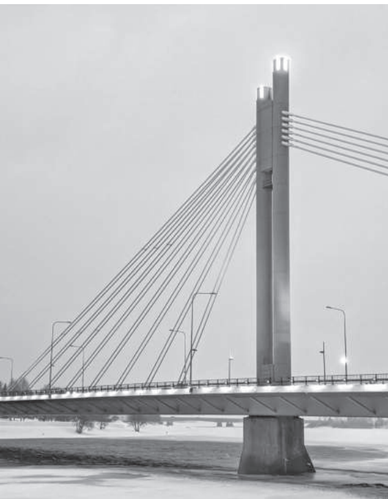
A Jätkänkynttilä híd
