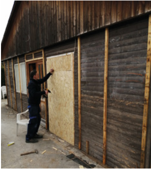
Zajlik a büféépület felújítása
