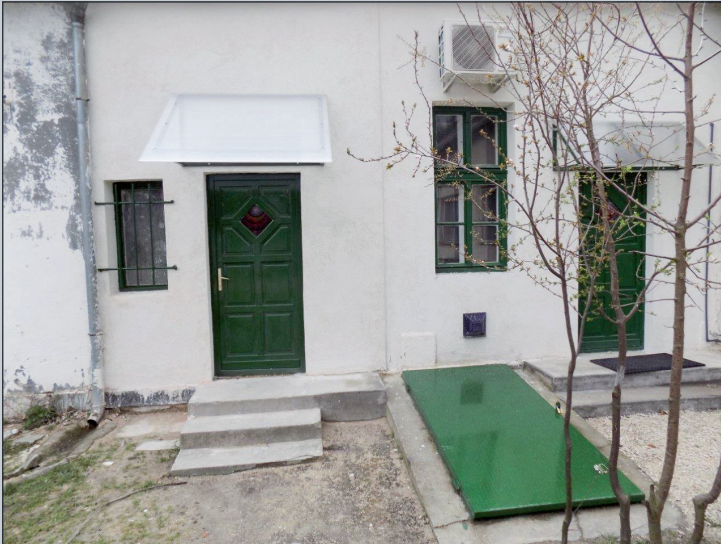
Puskin u. 8.: vakolatfelújítás, előtető, új pinceajtó készítése
