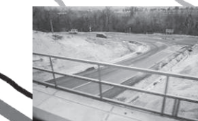
Órhegy utca: Új híd és csatlakozó útszakaszok épültek.
