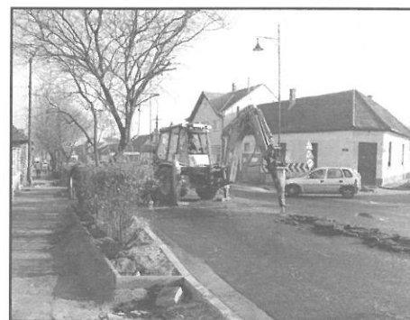
Finisébe érkezett a jelzőlámpás kereszteződés építése: a munkagép megkezdte a terelősziget kialakítását
