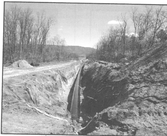
A gázvezeték összehegesztett szakasza a ligeti lovarda (volt tsz) mellett
