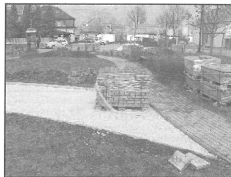
Épülőfélben a Hősök téri parkolók és járda
