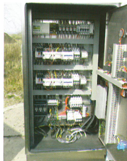
Elektromos szekrény felújítást követően
